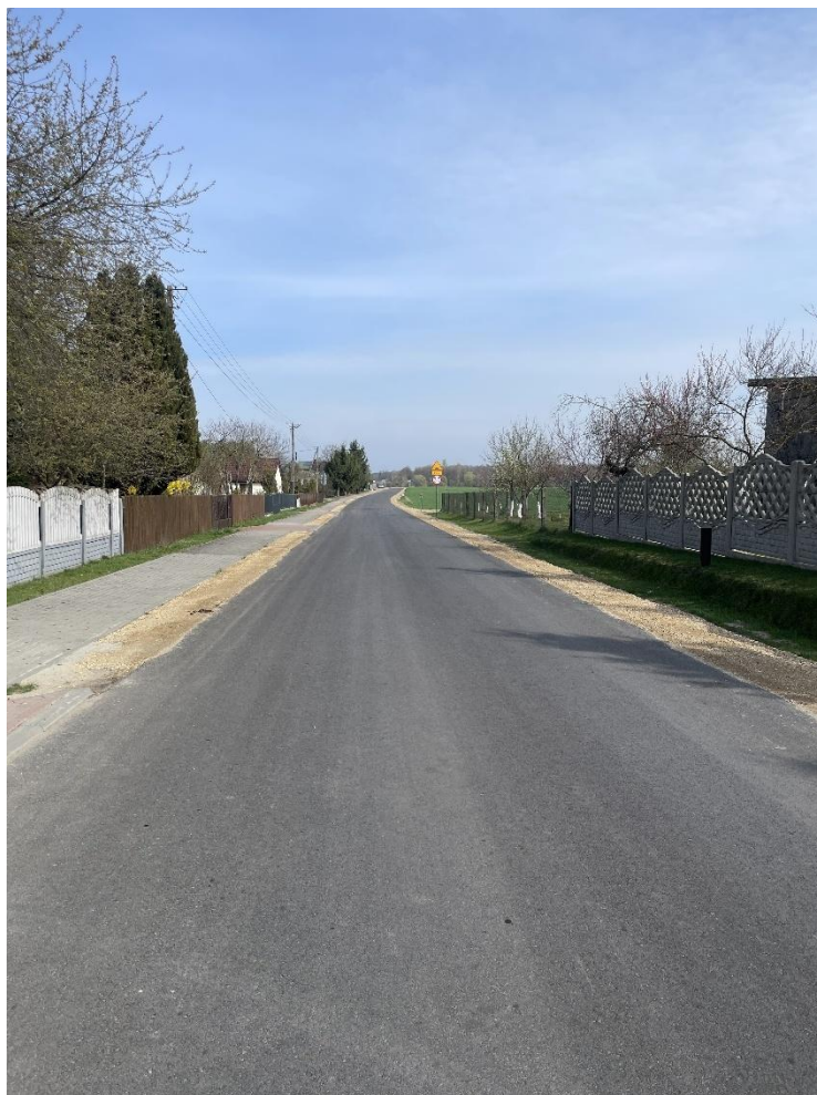
Zdjęcie 5.2.6. Przebudowa drogi gminnej nr DG112401E w Tworowicach
