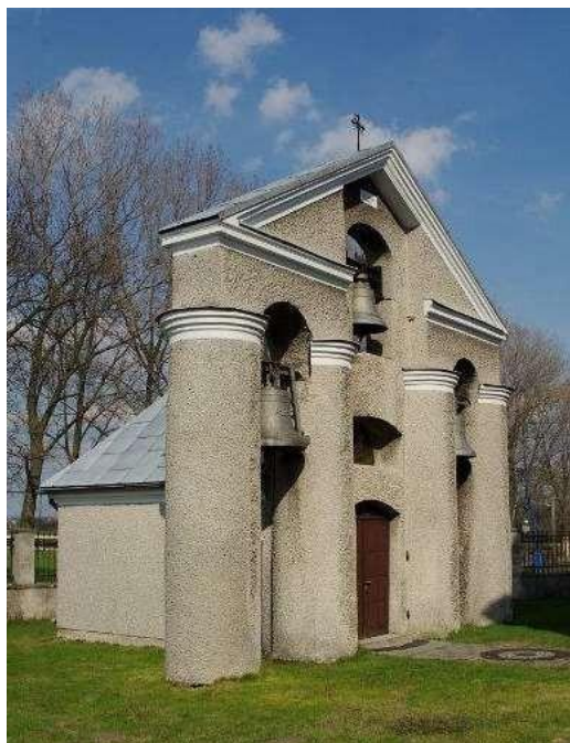
Zdjęcie 6.7.2. Dzwonnica w zespole kościoła ob. kaplica przedpogrzebowa- XIXw.
