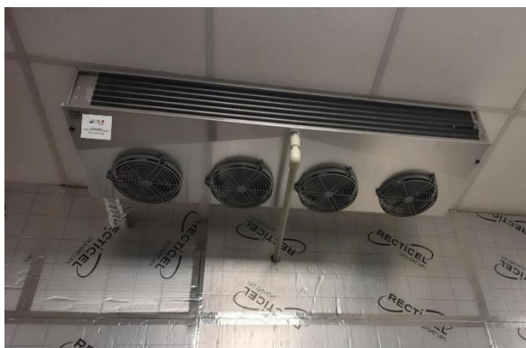
Zdjęcie 5.4.8. i 5.4.9 Agregat chłodniczy do chłodni w budynku strażnicy OSP w Kraszewicach
