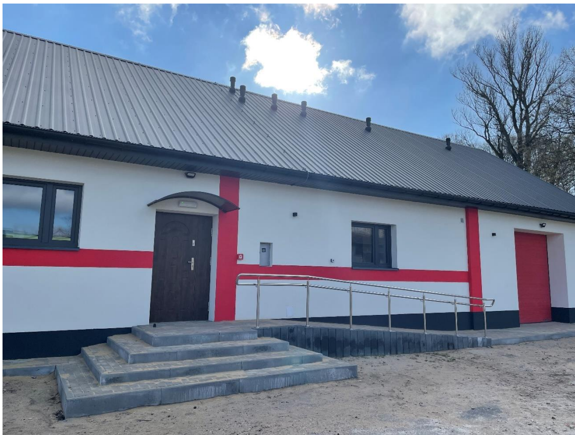
Zdjęcie 5.3.1 - Termomodernizacja budynku OSP w Bartodziejach
