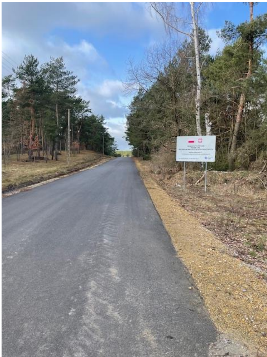
Zdjęcie 5.2.15 - Przebudowa drogi gminnej w m. Bartodzieje na dz. 530 w ramach zadania „Przebudowa dróg na terenie Gminy Masłowice”
