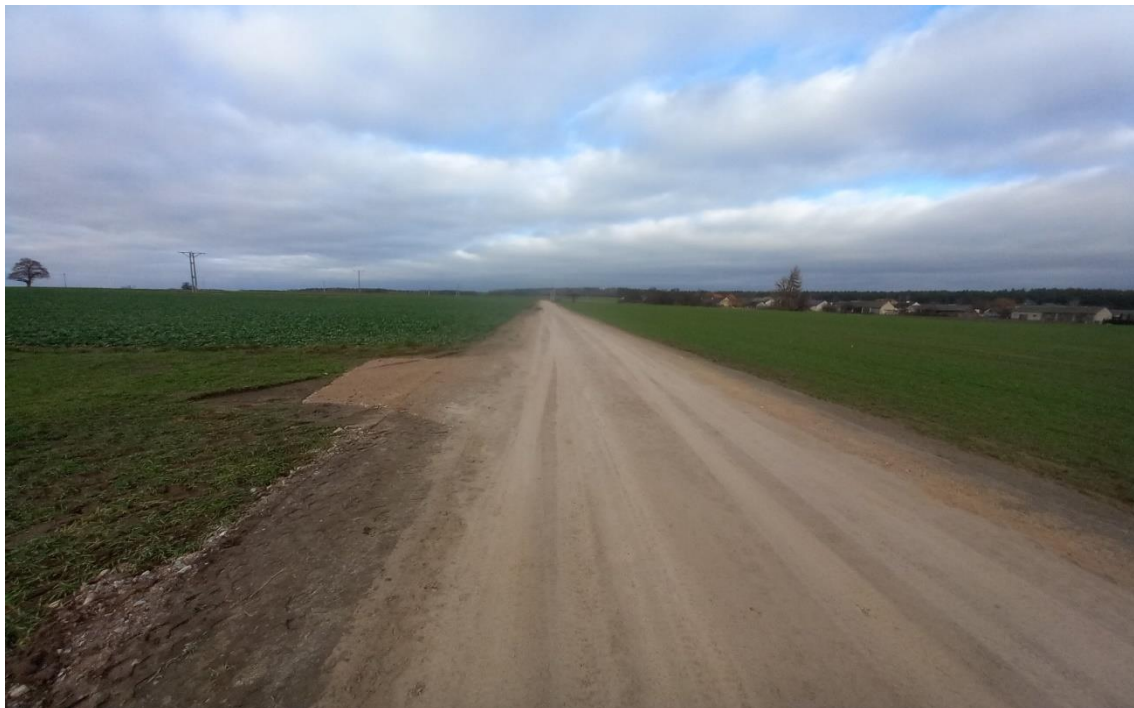
Zdjęcie 5.2.8 - Przebudowa drogi wewnętrznej Kalinki na działce o nr ewid. 65
