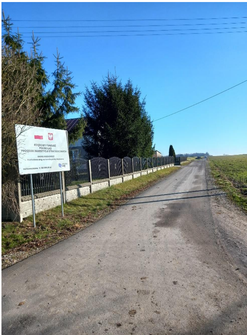
Zdjęcie 5.2.17 - Przebudowa drogi wewnętrznej w miejscowości Korytno na działce o nr ewid. 634w ramach zadania „Przebudowa dróg na terenie Gminy Masłowice”
